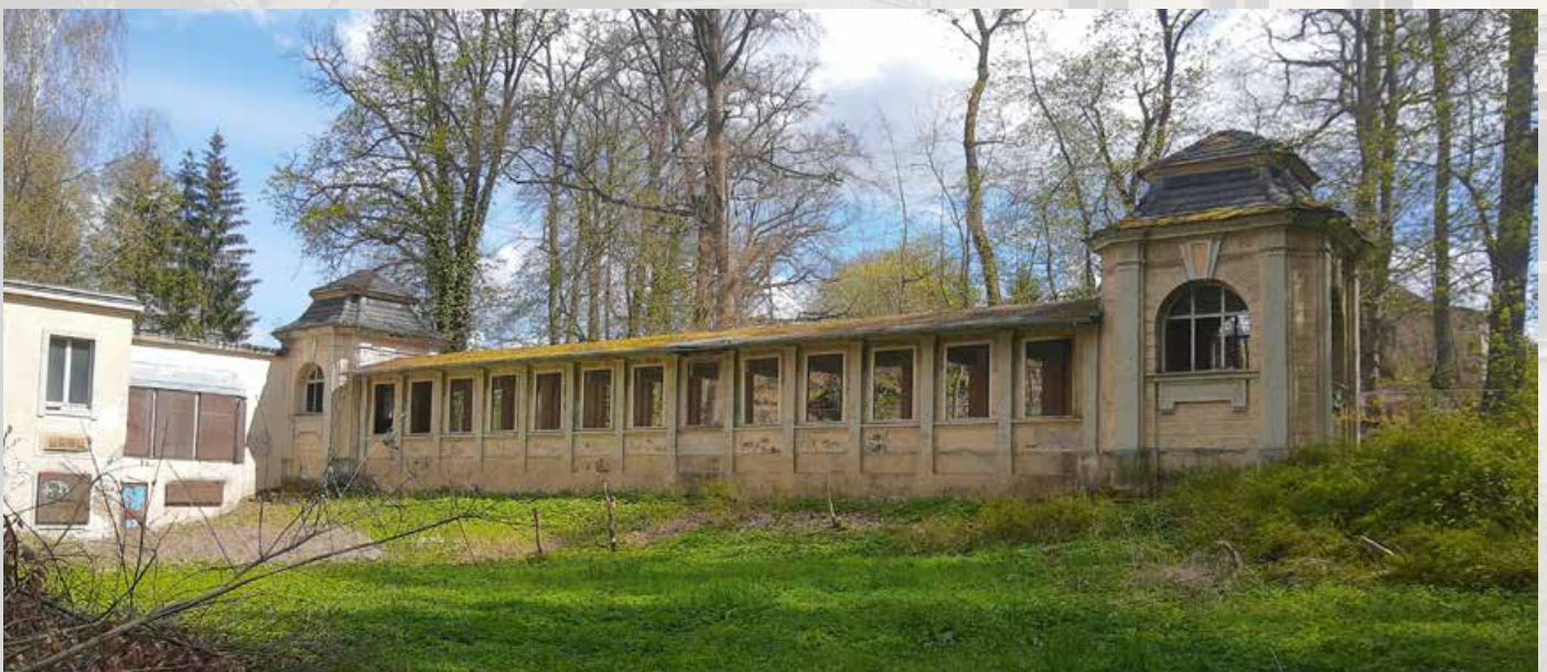
Der alte Wandelgang: Hier war eine Kegelbahn eingebaut
