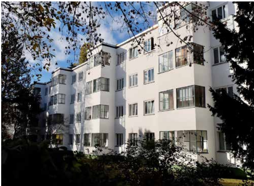
Die Häuser um das Denkmal wurden vor Jahren zurück in den weißen Originalzustand versetzt.
