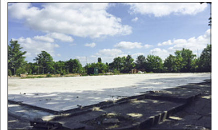
Baugrundstück an der Ernststraße. Foto: tan
