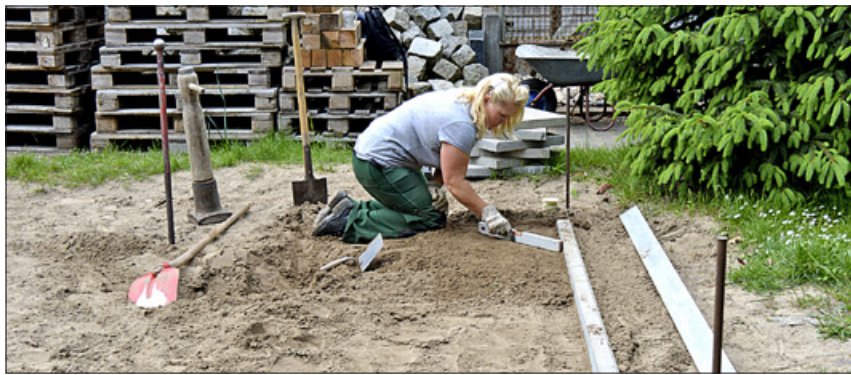
Silena Güntersberger verlegt eine Pflasterkante.
