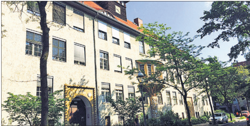
Die Benjamin-Franklin-Oberschule wird in mehreren Bauabschnitten saniert.
