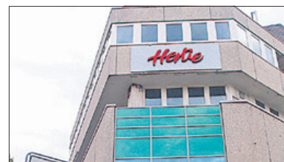
Die Baumaßnahmen am Hertie-Haus sollen Mitte nächsten Jahres beginnen. Foto: tan
