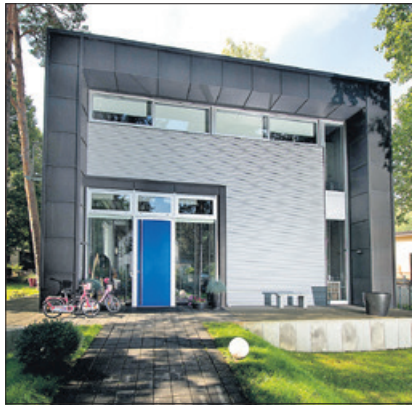
Das ursprüngliche Rahmenhaus aus Stahl, Holz und Stein. Foto: privat
