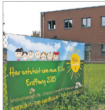
Die offizielle Eröffnung der Kita wird am 19. September gefeiert. Foto: hb
