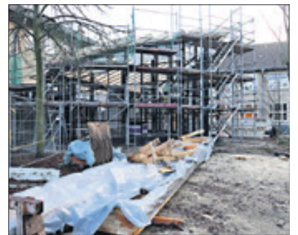
Die Mensa wird nun Stück für Stück fertiggestellt.
