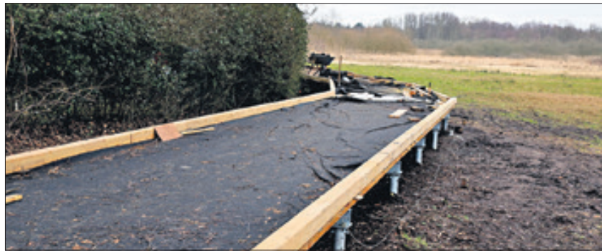
Die Bauarbeiten an der AEG-Steganlage ist im vollen Gange und wird voraussichtlich in diesem Monat fertig.
