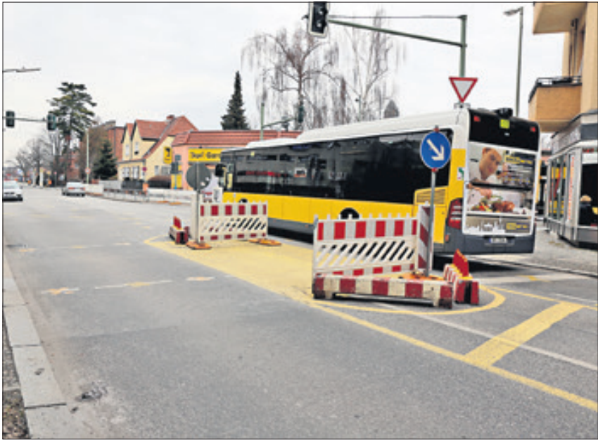
Die Kreuzung wurde kurzfristig einspurig umgebaut.
