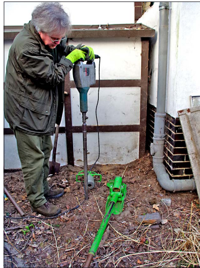
Andreas Zill bei der Arbeit – ob dieser Boden sich als Baugrund eignet? Foto: mvo
