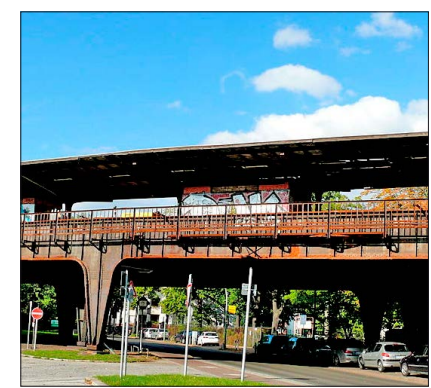
S-Bahnbrücke am Rohrdamm.
