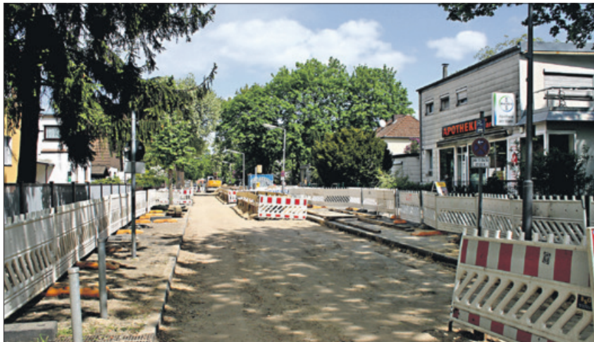
Im Bekassinenweg wird zwischen den Straßen Am Erpelgrund und Wildganssteig gebaut. Dieser Straßenabschnitt bleibt voraussichtlich bis November gesperrt.
