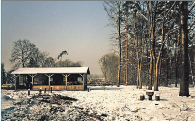
Die Trasse der Bundesfernstraße in Blickrichtung S-Bhf. Schulzendorf – nach der Rodung. Der Pavillon wurde abgebaut und eingelagert.
