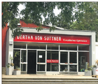
Der Eingang des Gymnasiums.
