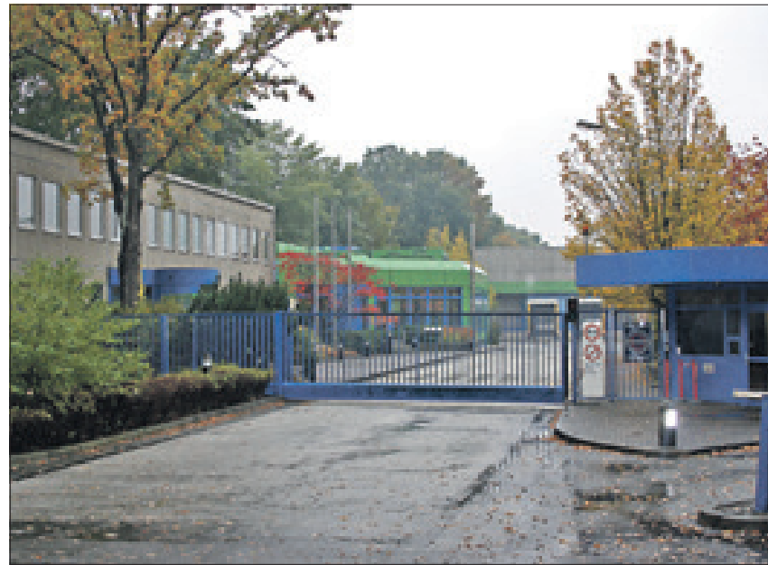
Die Pläne für ein Flüchtlingsheim auf dem ehemaligen Tetra-Pak-Gelände sind vom Tisch.
