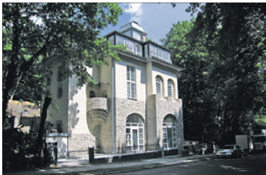
Der Um- und Ausbau des Umspannwerks sind so gut wie abgeschlossen.
