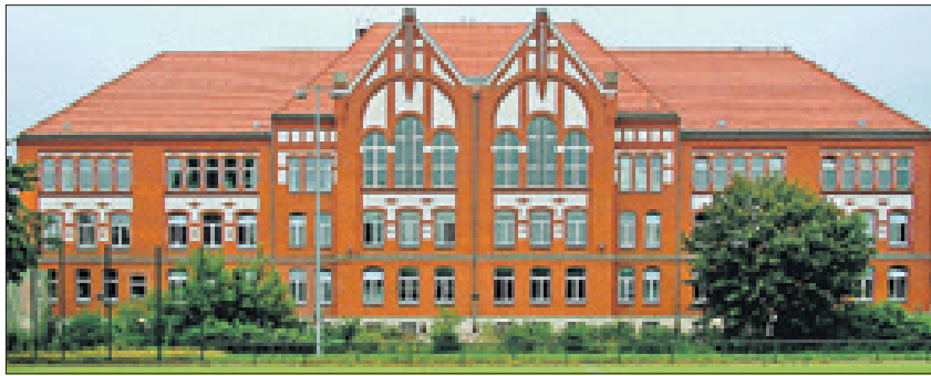
Der rote Bau ist ein Hingucker im Ortsteil.
