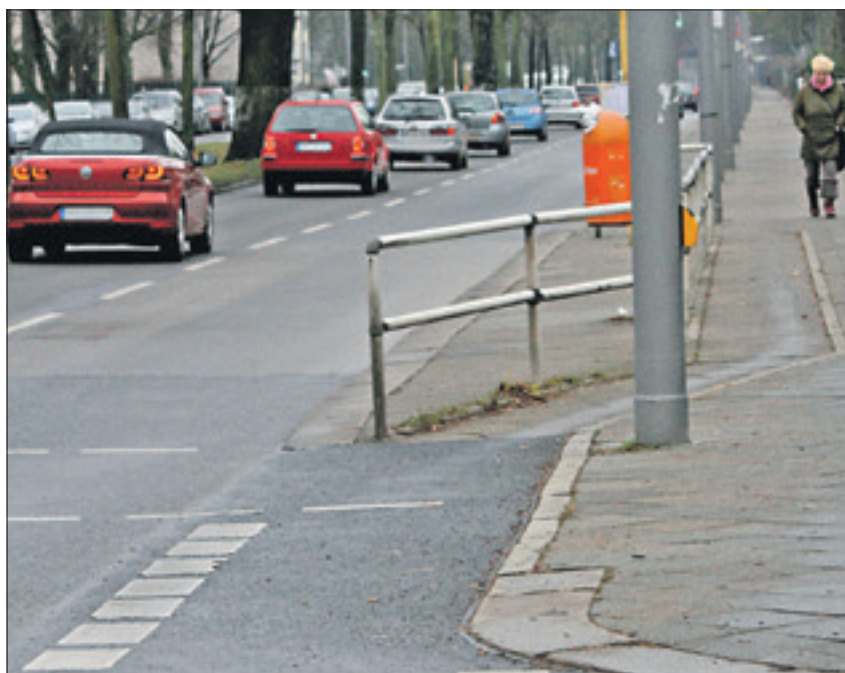
Schlaglöcher werden durch den Neubau der Oranienburger Straße beseitigt.
