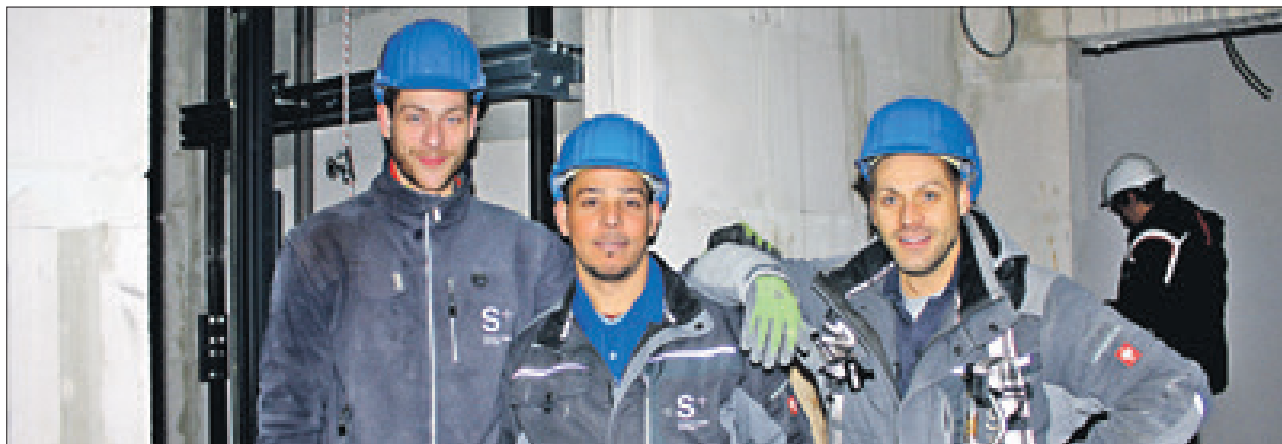
Steffen Heise, Ihab Habeeb und Kevin Zegke (v.l.) bei der Montage des Aufzugs in Oberschöneweide
