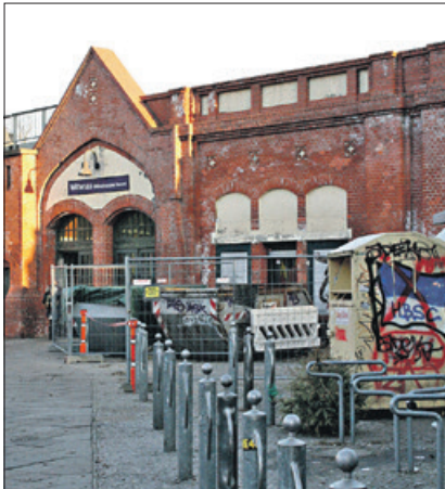
Derzeit wird der Nordeingang des S-Bahnhofs Wittenau saniert. Foto: as
