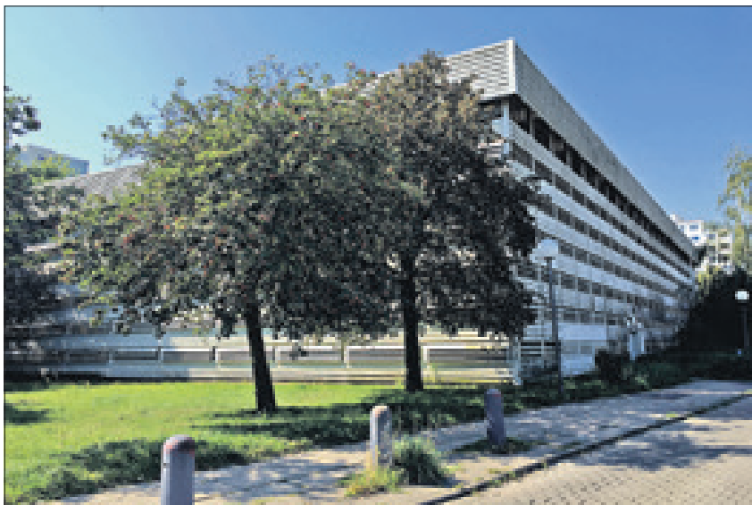
Dieses Parkhaus an der Finsterwalder Straße 102A wird erst abgerissen, wenn auf der anderen Fläche das neue Parkhaus steht. Dann allerdings muss es einem Wohnhaus weichen.
