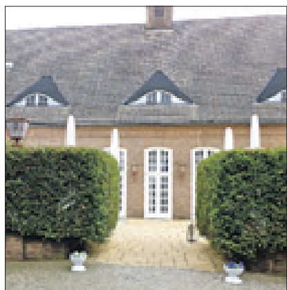
Das Landhaus residiert im denkmalgeschützten Gebäudeensemble.
