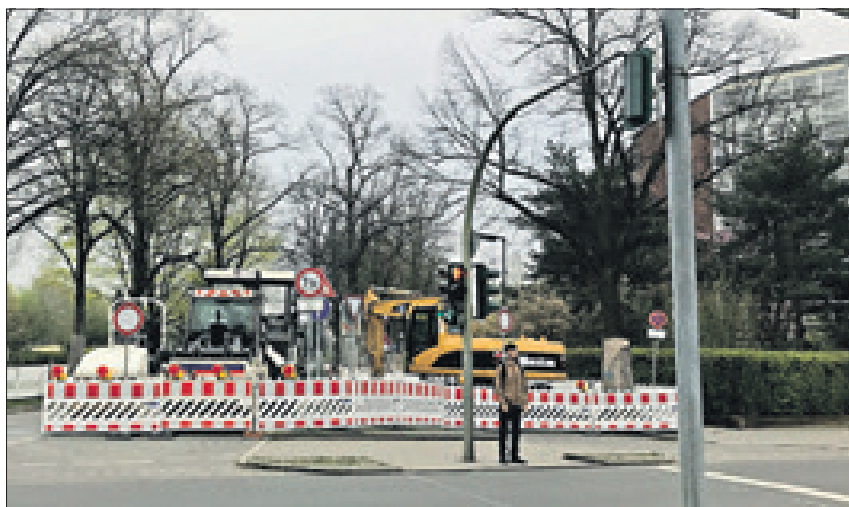
Die Cyclopstraße ist zurzeit gesperrt und wird zur Umfahrungsstraße umgebaut.
