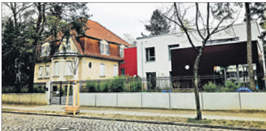
Das Kitagebäude in Hermsdorf, bestehend aus Alt- und Neubau
