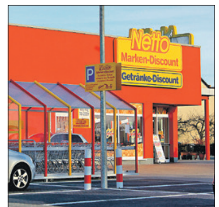
Flächen wie diese werden auf Verdichtung geprüft. Foto: Wikiimages CC0
