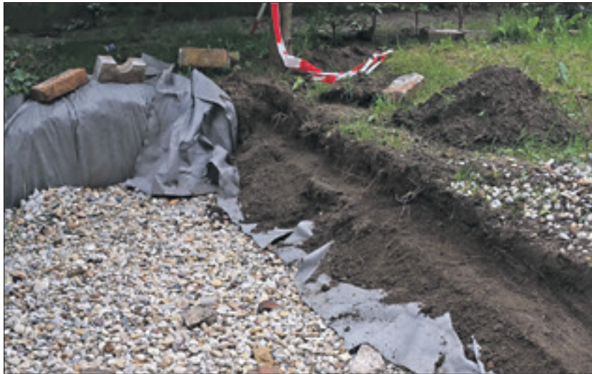
Hier wird eine Rigole in einen Garten eingebaut, damit Regenwasser besser abfließt. Foto: mvo
