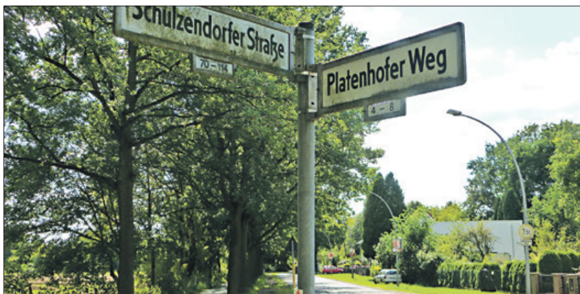
Die Schulzendorfer Straße hat ein Problem mit Oberflächenwasser.
