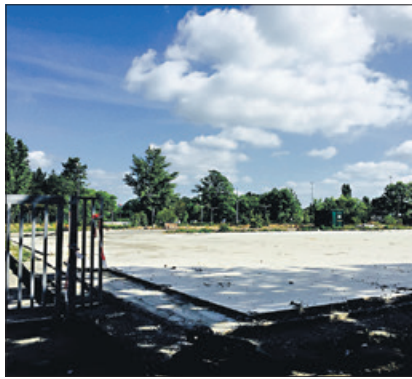
Nach dem Abriss des Gebäudes lag das Gelände mehrere Jahre brach.
