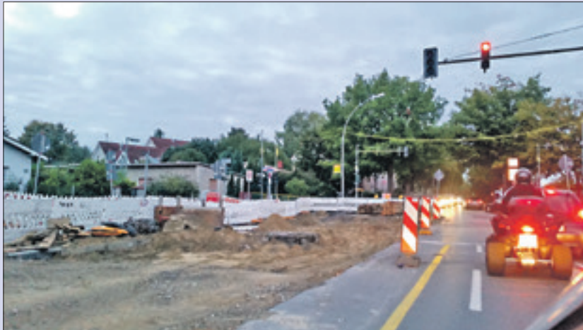
In der Oranienburger Straße ist eine Fahrbahnseite wegen Bauarbeiten gesperrt. Foto: hb
