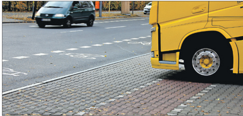
Am Eichborndamm: Muss man sich wirklich beklagen, dass für die Radfahrer ein Streifen auf der Straße geschaffen wurde? Foto: bek
