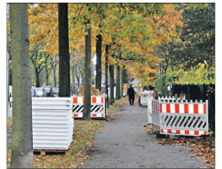
In der Schulzendorfer Straße wird die Gasleitung erneuert. Foto: hb
