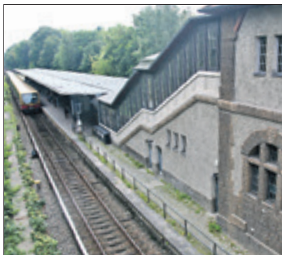
Endhaltestelle für den Kiezbuss ist der S-Bahnhof Frohnau.
