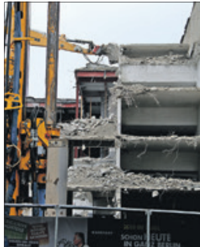
Abrissarbeiten in Tegel
