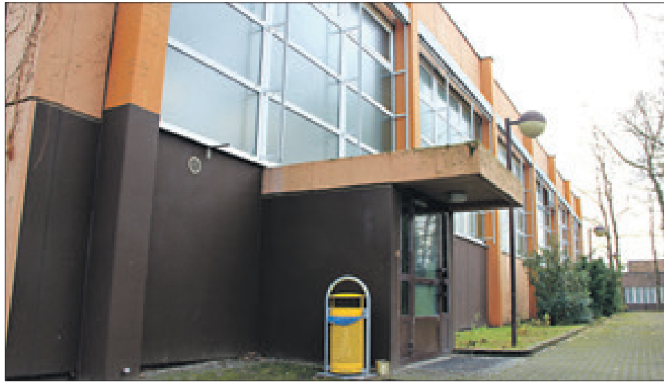
Soll im Juni wieder ihrer eigentlichen Bestimmung zugeführt werden: die Halle des OSZ an der Cyclopstraße. Foto: bek
