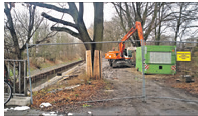
Baustelle Nordgraben/Schorfheidestraße Mitte Dezember Foto: mfk
