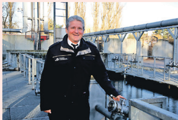
Andreas Schmiegel vor der Pumpenübungsanlage.
