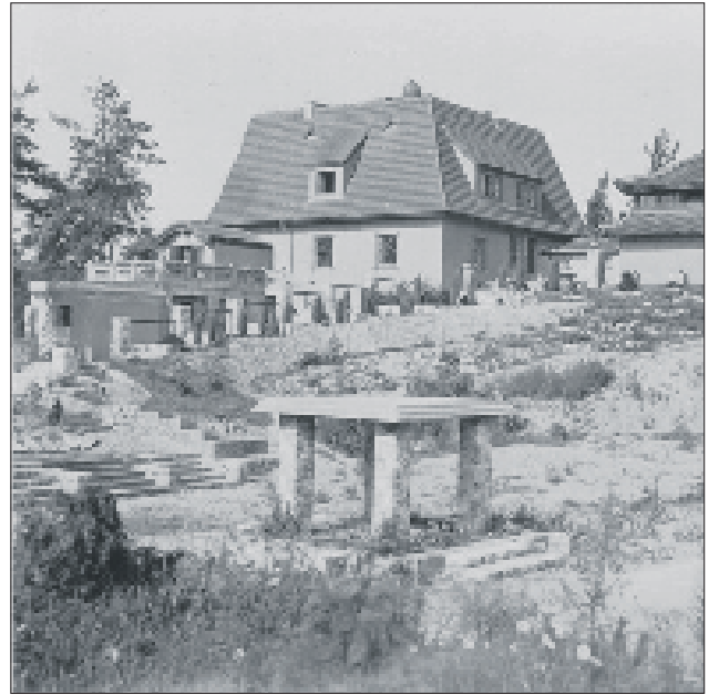
Die Gesamtanlage kurz nach der Fertigstellung
