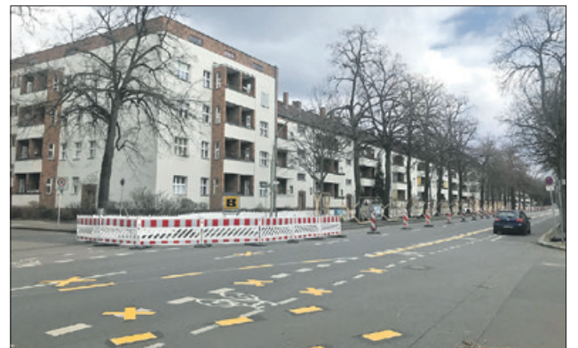
Zwischen Bollestraße und Marzahnstraße wird gebaut. Foto: fle
