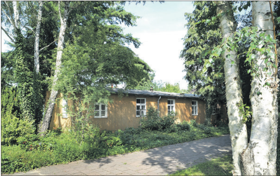
Eine Baracke des ehemaligen Gemeinschaftslagers Krumpuhler Weg
