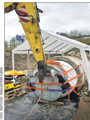
Einsatz des Inliners
