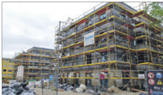
Der Wohnungsneubau in der Cité Foch
