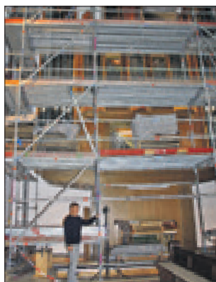
Martin Rathmann vor der eingerüsteten Orgel
