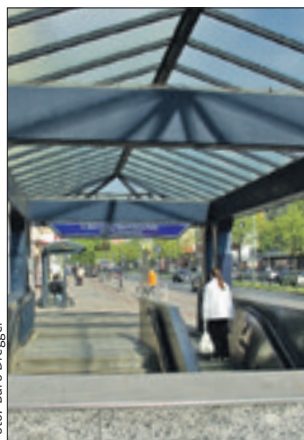
Der Ausgang zum Schäfersee ist wegen Sanierung nicht nutzbar.
