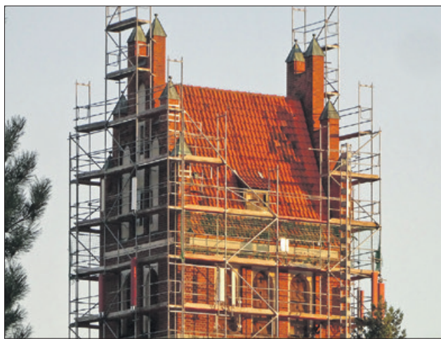
Der eingerüstete Kirchturm
