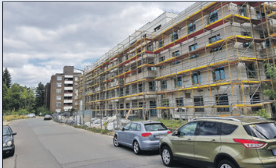
In der Cité Foch entstehen neue Wohnungen. Parkplätze könnten hier knapp werden.
