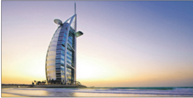
Schwingungstilger aus Reinickendorf kommen in einem der teuersten Hotels der Welt zum Einsatz – das Burj al Arab Hotel in Dubai.
