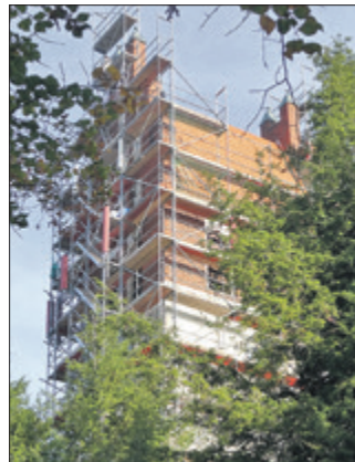
Der noch eingerüstete Turm der Königin-Luise-Kirche. Foto: privat
