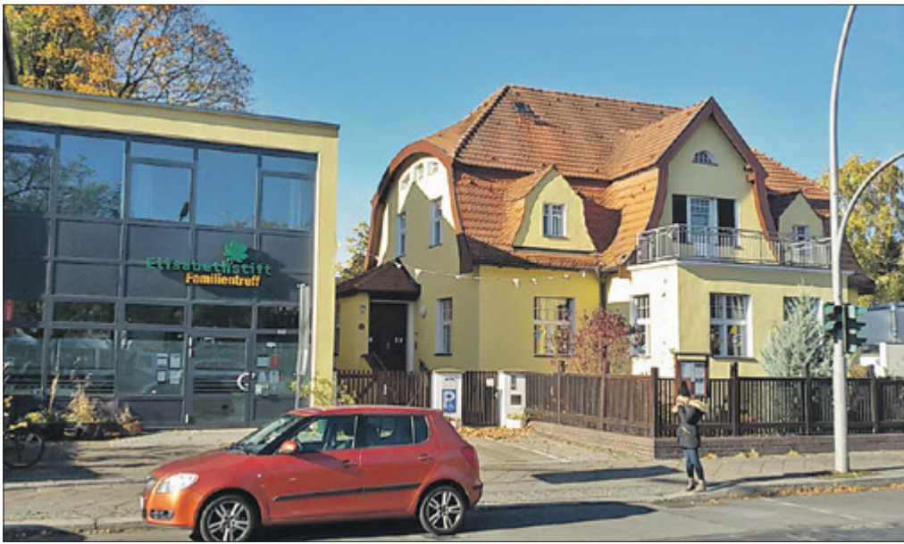
Im Neubau ist der Familientreff untergebracht, nebenan in der sanierten Villa die Kita.
