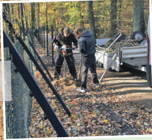
Das Schwarzwildgatter im Tegeler Forst erhält einen neuen 750 Meter langen Zaun. Fertigstellung: Ende November, Anfang Dezember Foto: Frank Mosch
