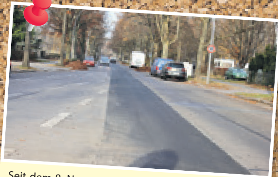
Seit dem 8. November wird die Hermsdorfer Straße von Alt-Wittenau bis zur Cyclopstraße instandgesetzt. Das Ende der Bauarbeiten ist für den 21. Dezember angekündigt, aber das Teilstück von Alt-Wittenau bis Lange Enden ist schon fertig. Hier sind die Baken schon abgebaut und kann der Verkehr wieder frei fließen. Rund 2.000 Quadratmeter in der Mitte der Fahrbahn werden neu asphaltiert, die Baukosten von rund 189.000 Euro werden aus dem Schlaglochanierungsprogramm der Senatsverwaltung für Umwelt, Natur und Klimaschutz finanziert. Foto: bek
