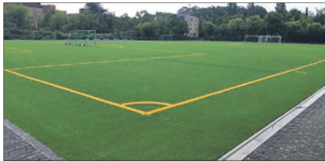
Die Sanierungsarbeiten am Fußballplatz sind nun abgeschlossen. Foto: BA Reinickendorf
