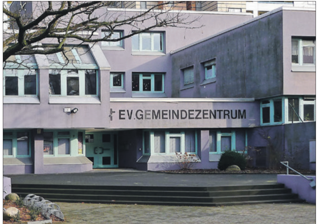
Nach dem Abriss entsteht hier das neue Familien- und Begegnungszentrum mit (neu) 60 darüberliegenden Wohnungen. Foto: Von Bodo Kubrak - CCO
