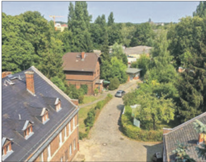
Blick von oben auf das Wasserwerk Tegel
