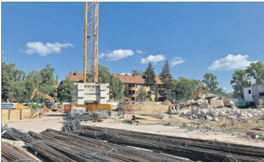
Hier soll bald ein fünfstöckiges Studentenwohnheim stehen.
