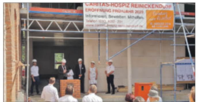
Der Neubau des Caritas-Hospizes bezieht das denkmalgeschützte Katharinenhaus mit ein. Foto: Falko Hoffmann
