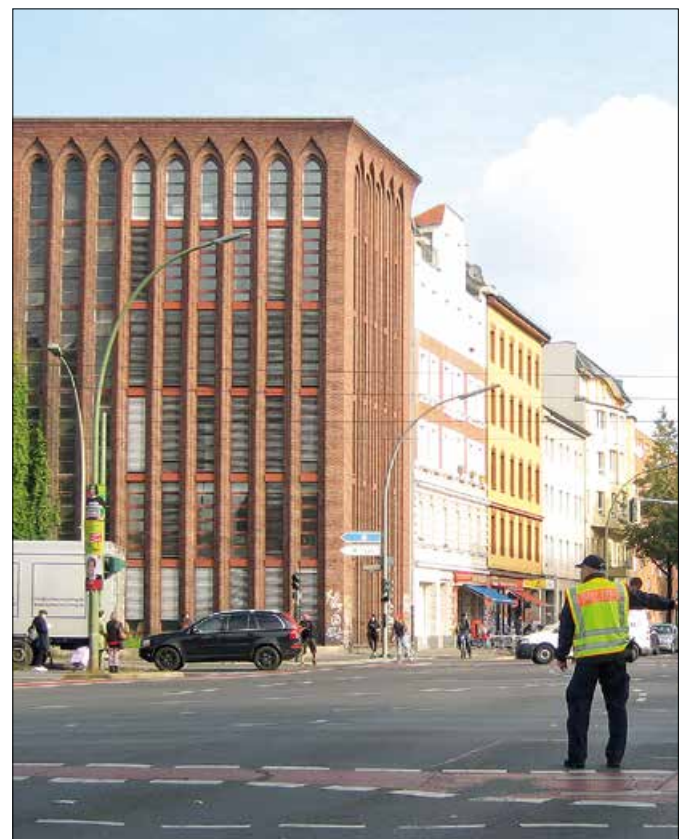
Das ehemalige Umspannwerk Christiania an der Kreuzung Prinzenallee und Osloer Straße ist ein Denkmal.
