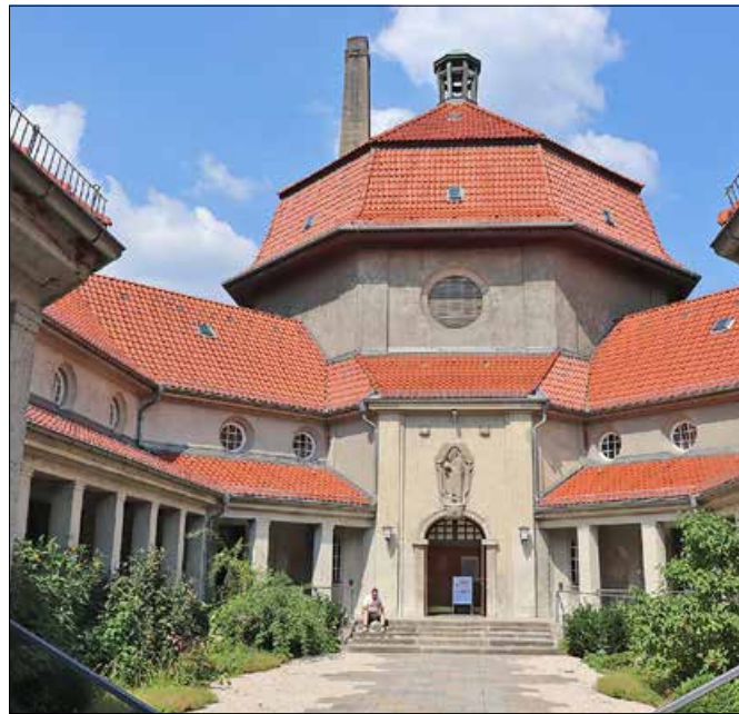
Kulturstandort Silent Green im ehemaligen Krematorium
