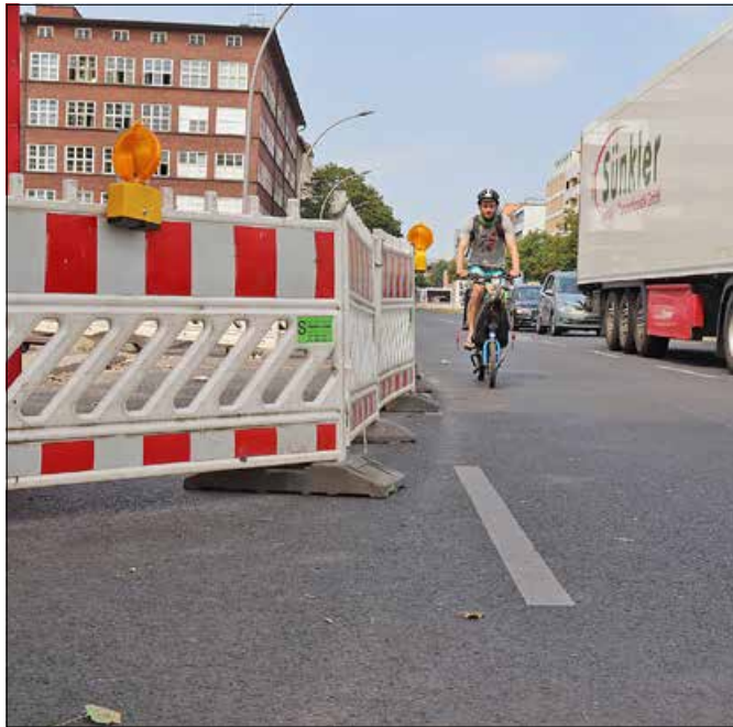
Nur eine Baustelle, kein Pop-Up-Radweg auf der Müllerstraße Foto: as
